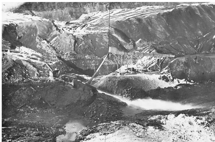
Общий вид Промприбора на полигоне в Хомолхо.
