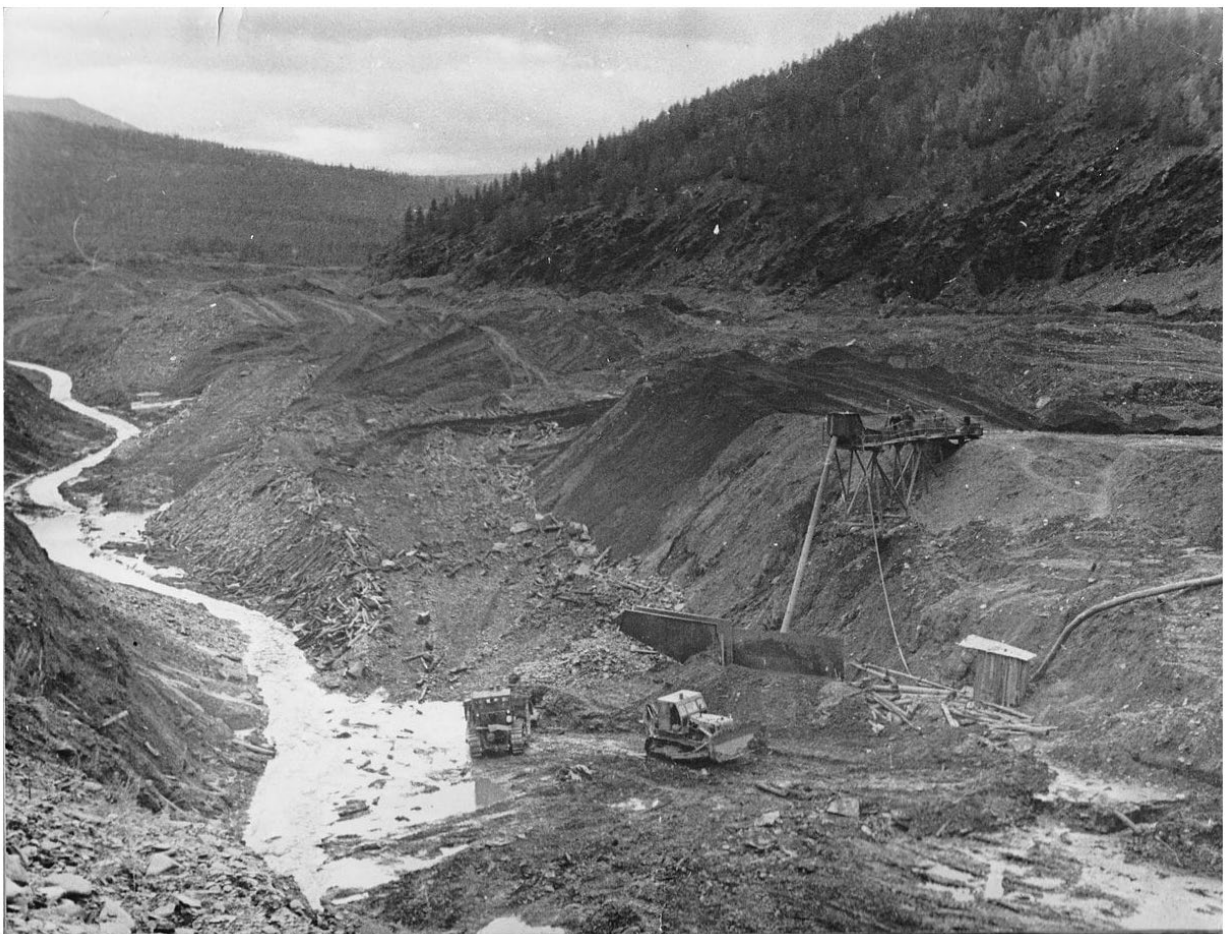
На снимке: добыча золота на гидроэлеваторе. Хомолхо. Из архива Сергея Геннадьевича Зими́на. [11]
